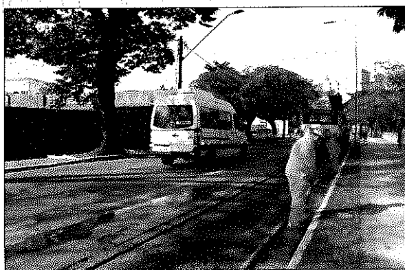
Obra de recuperação do asfalto em ponto de ônibus
